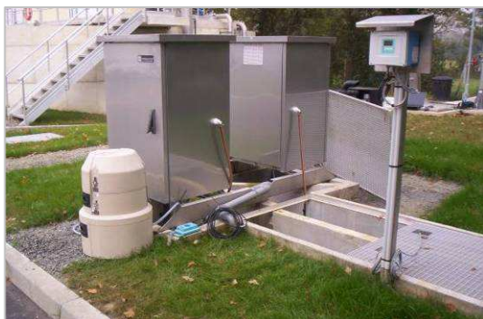
Essai de garantie sur une station d'épuration
